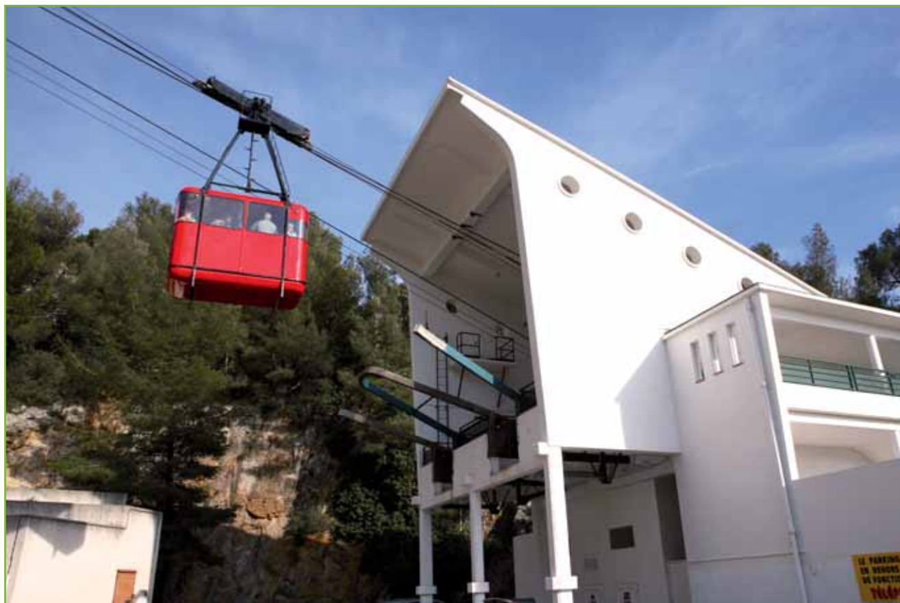
Après celle de l'arrivée, la gare de départ du téléphérique a été requalifiée pour un meilleur accueil des visiteurs.
